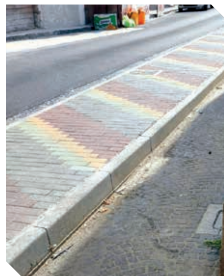
Il marciapiede di via De Chiara
